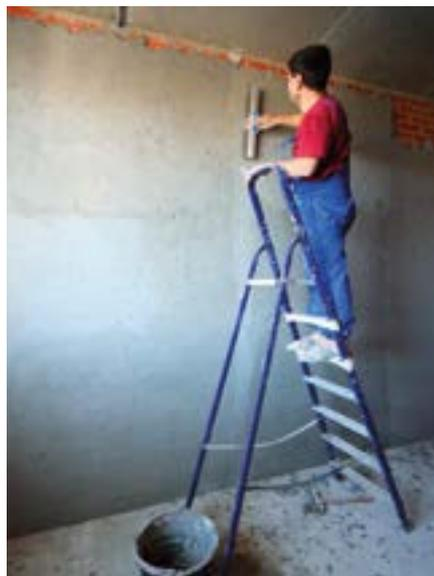
**M**ortero cementoso impermeabilizante flexible monocomponente para el tratamiento y reparación de defectos y agujeros en soportes expuestos al deterioro de la humedad.
