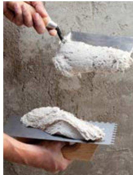
Enlucido de exterior a base de cemento, áridos de granulometría específica, fibra de vidrio y ligantes sintéticos que está indicado para la reparación de aristas, reperfilado de labios de junta, etc. en fachadas, para el revestimiento de elementos estructurales, regularización de superficies de hormigón y para el retapado de huecos y cavidades en soportes cementosos.
